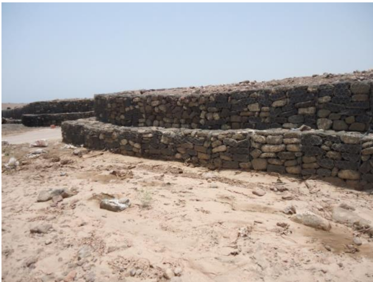
Figure (XX) exemple de la taille de gabions à Marsaki Les gabions ont une dimension standard de 1*1*2 soit 2m 3 .
