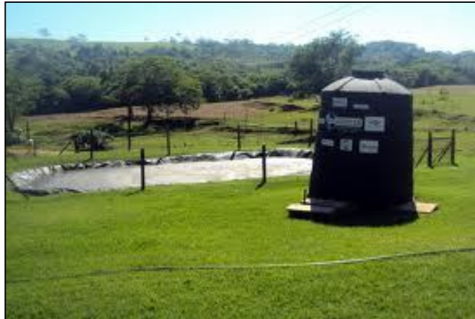
Figura 5.5 – Biodigestor Modelo Rígido de Fluxo Ascendente
