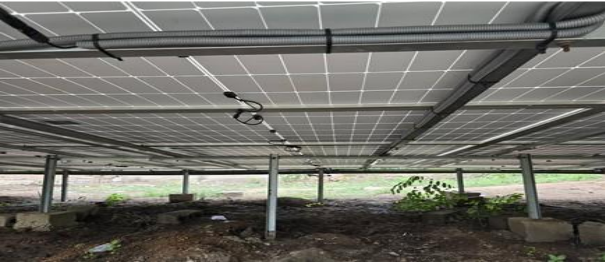
Installation des champs solaires
