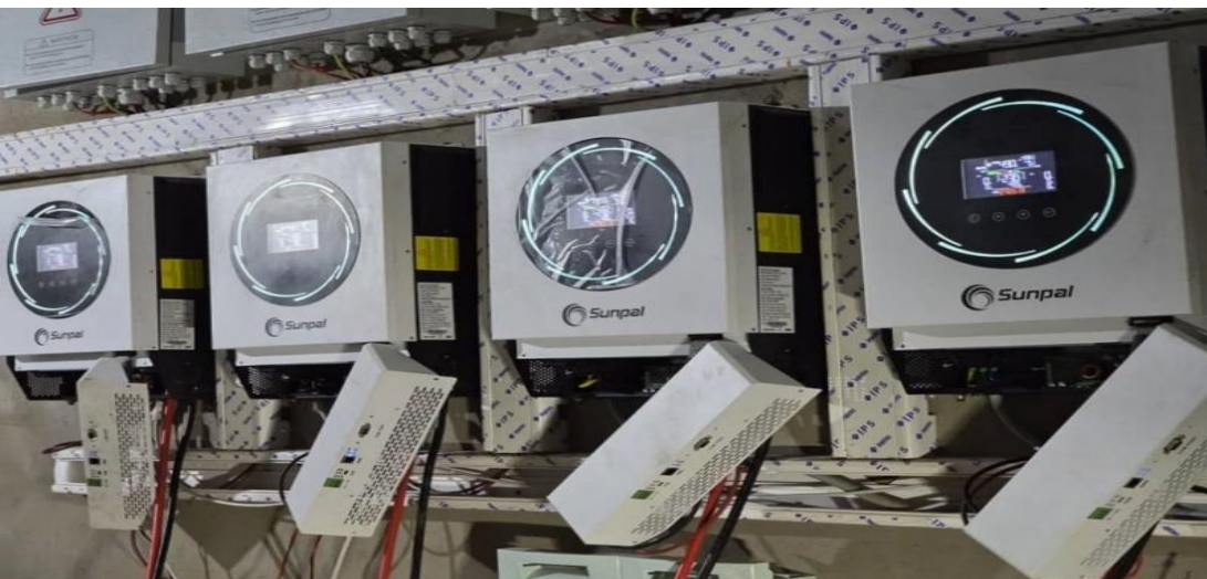
Installation des batteries
