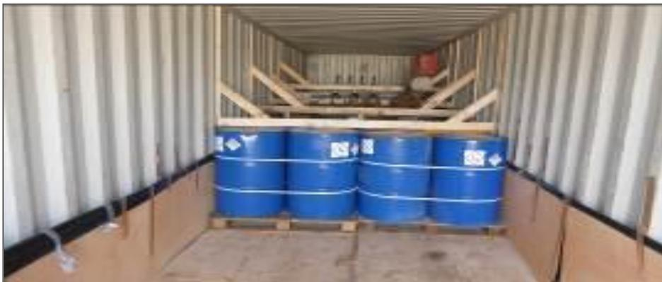
**Fig. : Fûts de PCB, stabilisés et bien callés dans le conteneur pour transport transfrontalier.**
