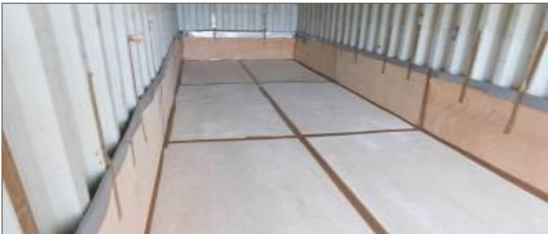
**Fig. : Mise en place de système de rétention étanche dans le conteneur.**
