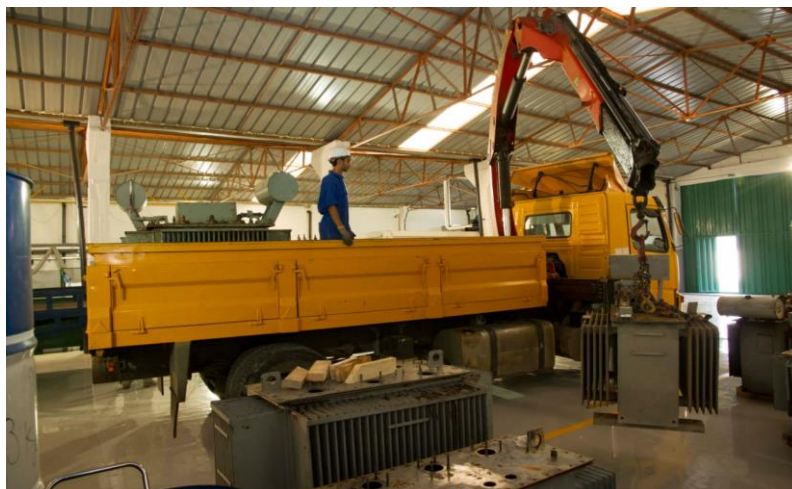
Figure 14 : Camion MME pour le transport des transformateurs contaminés
