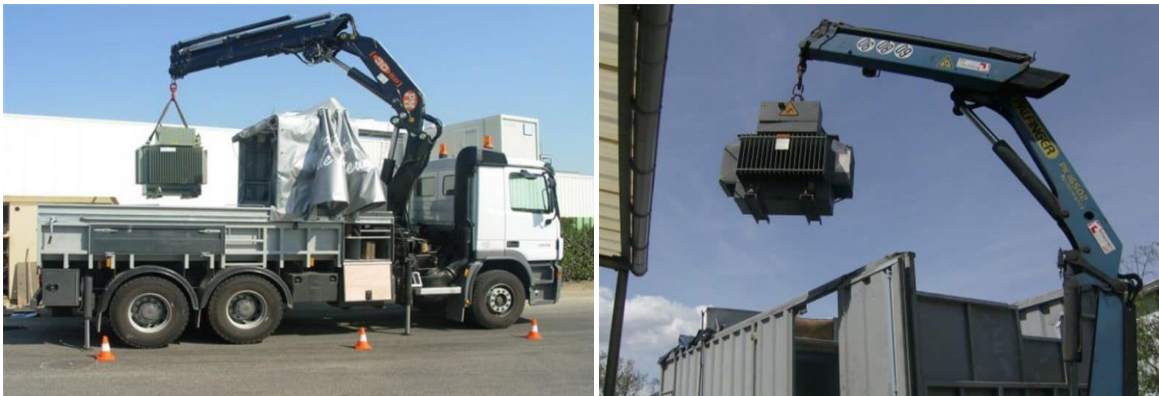
Figure 13 : Transport des transformateurs contaminés après vidange
