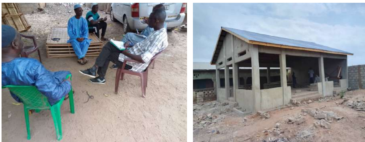
Figure 16 : Avec le Chief Bah et maison de justice en construction à Wassu (July 2024)
